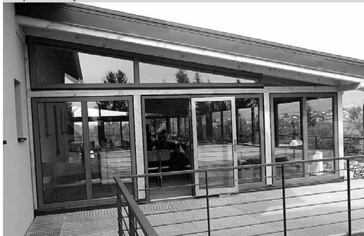
Nová terasa budovy penzión Bučník
