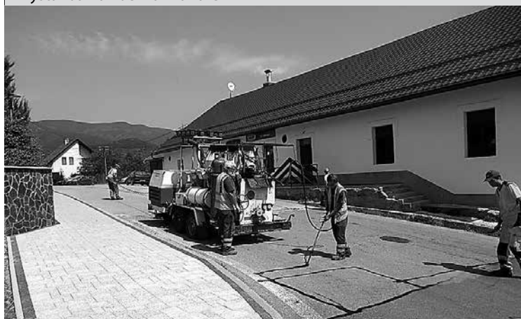
Oprava cesty na SNP ulici
