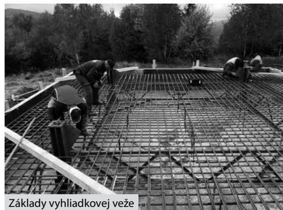
Základy vyhliadkovej veže
